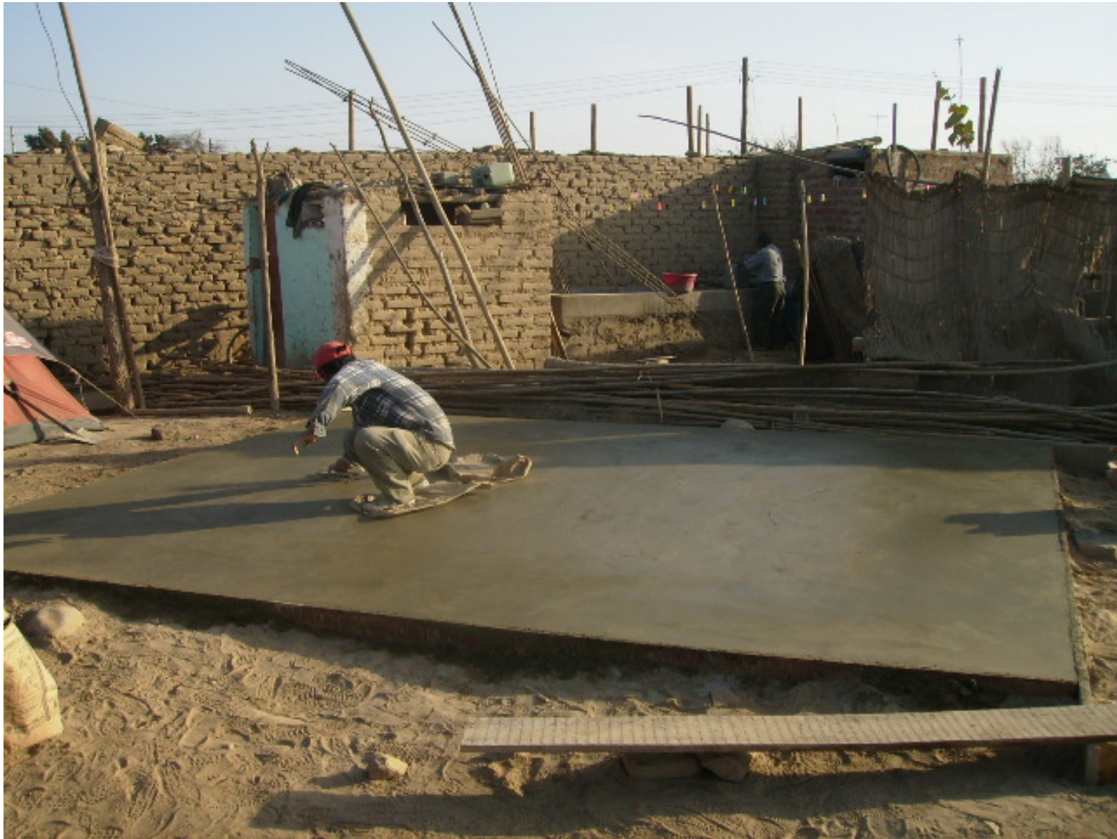
Costruzione della soletta in cemento
