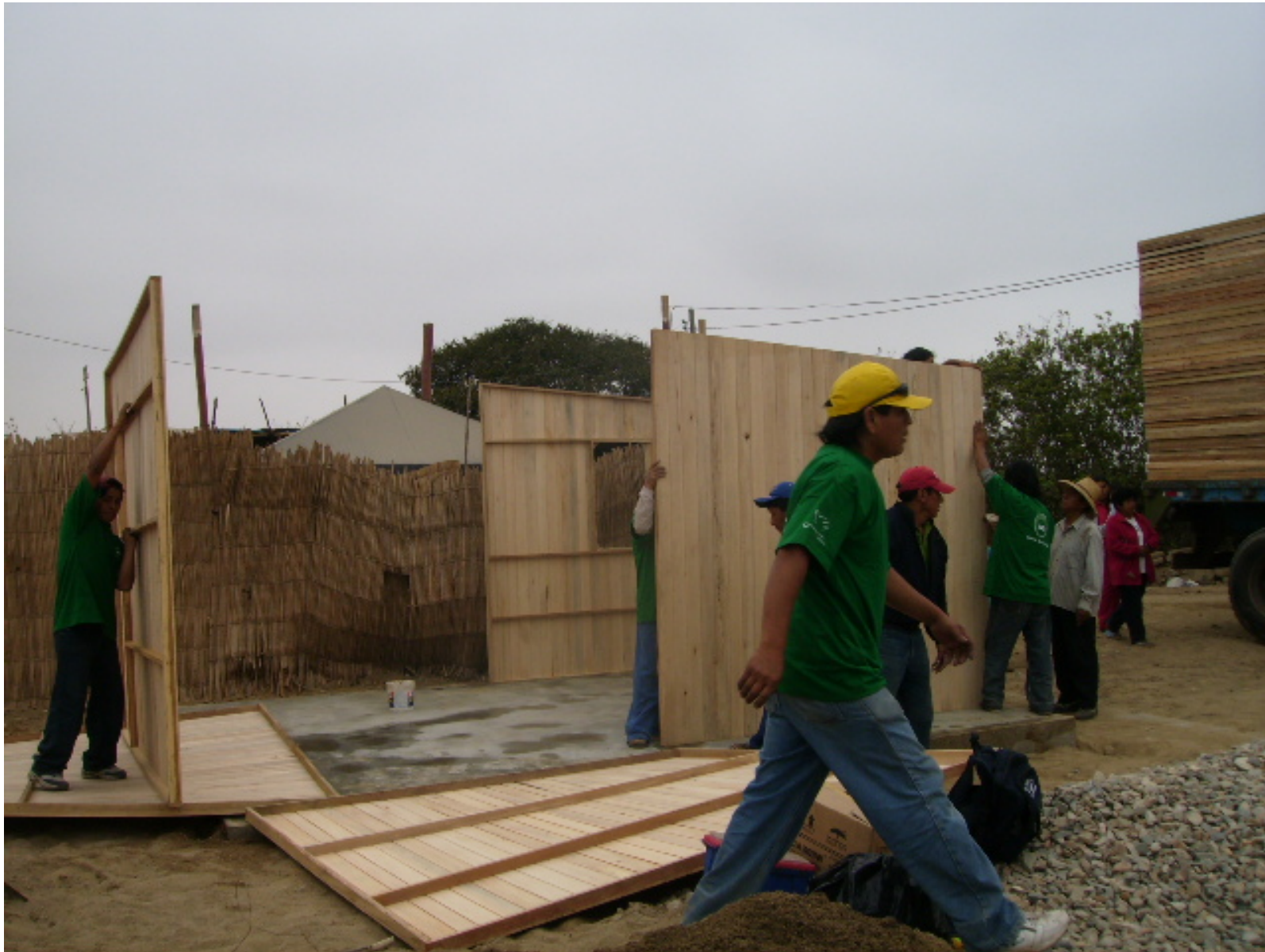
Montaggio dei prefabbricati di legno
