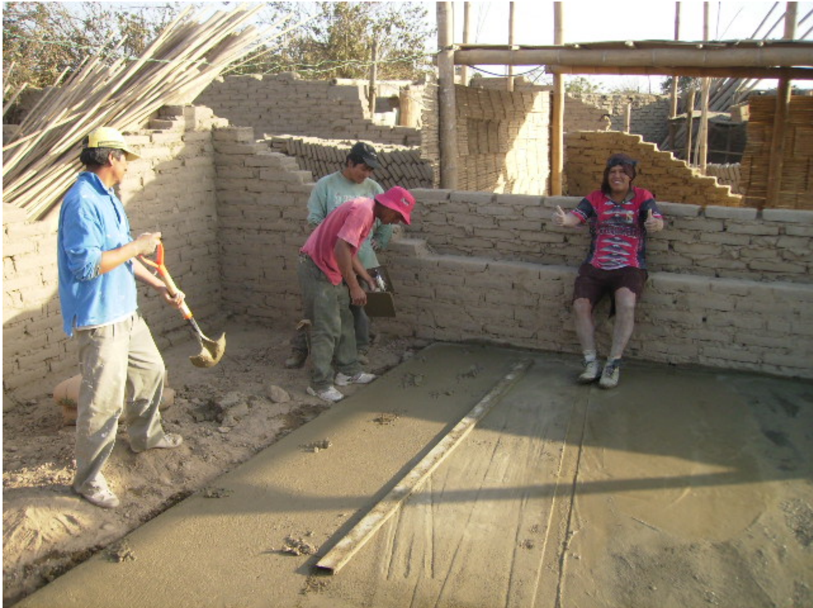
Costruzione della soletta in cemento
