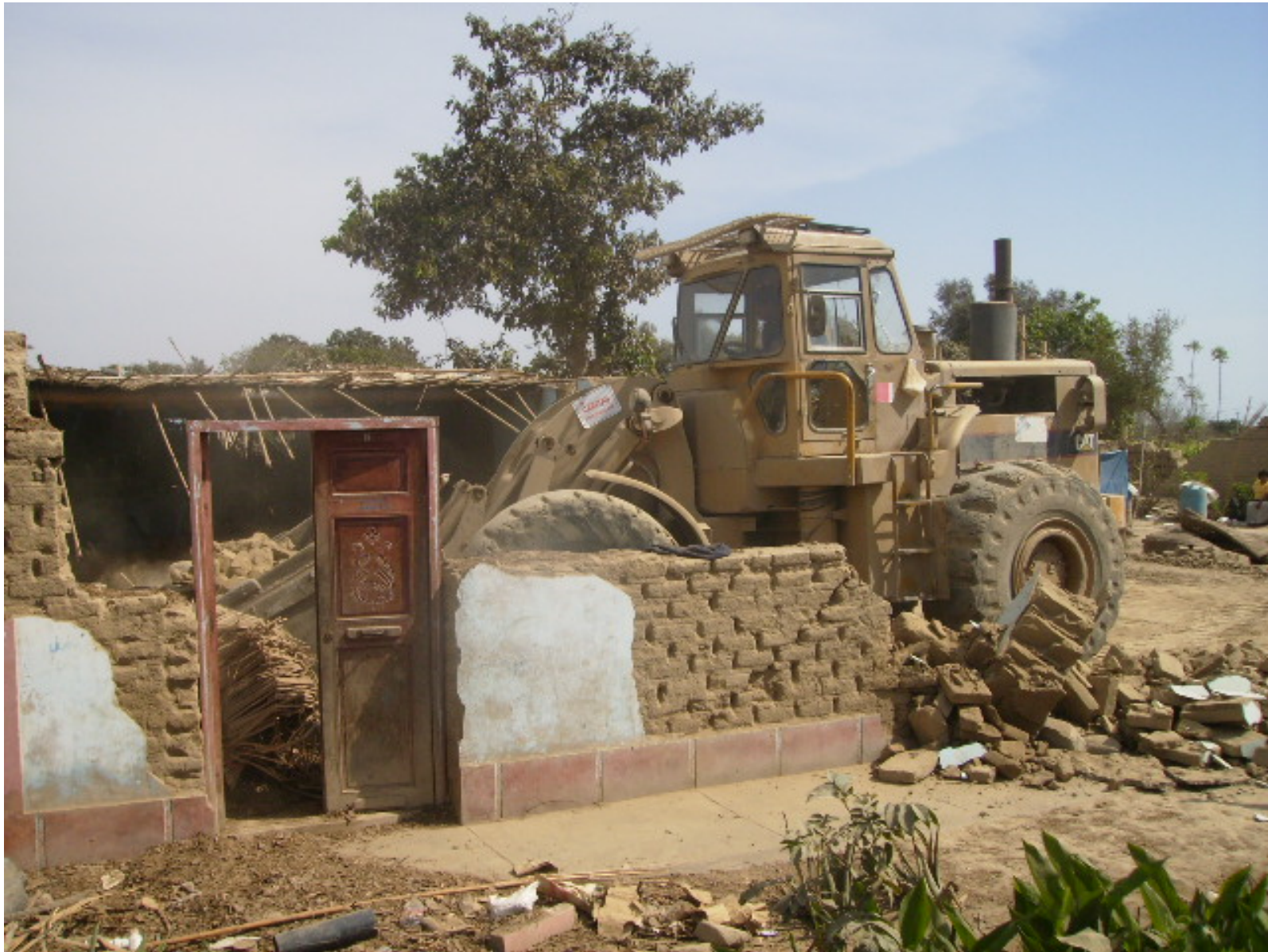
Demolizione e rimozione delle macerie
