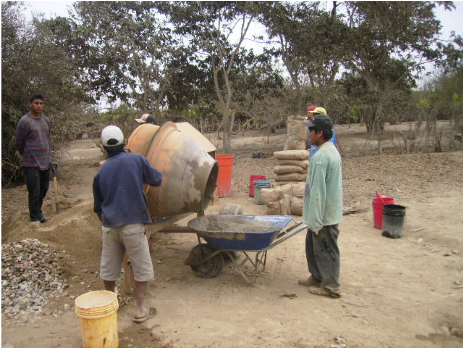
Costruzione della soletta in cemento
