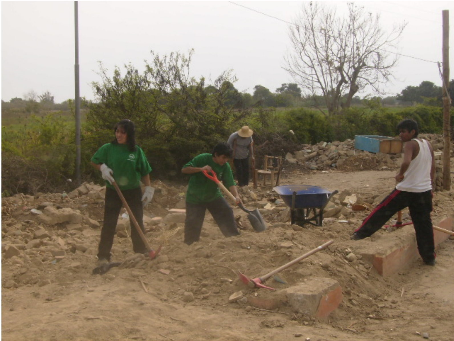
Demolizione e rimozione delle macerie
